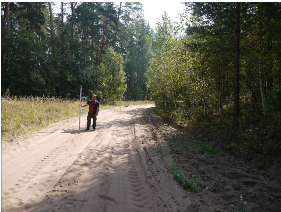
Рис. 70. Бузулукский район. Земельные участки, отводимые под объект «Обустройство кустовых площадок Могутовского и Гремячевского месторождений». Пункт фотографирования №22. Фото с северо-запада.
