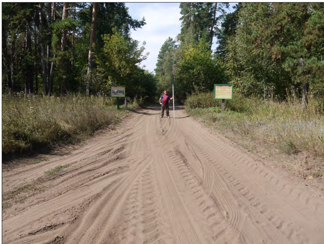
Рис. 82. Бузулукский район. Земельные участки, отводимые под объект «Обустройство кустовых площадок Могутовского и Гремячевского месторождений». Пункт фотографирования №28. Фото с востока.
