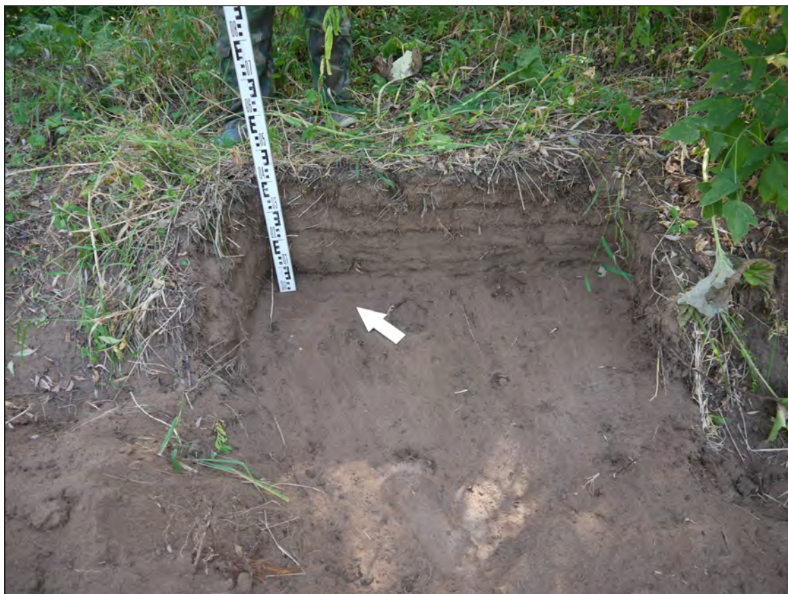
Рис. 58. Бузулукский район. Земельные участки, отводимые под объект «Обустройство кустовых площадок Могутовского и Гремячевского месторождений». Рекогносцировочный шурф №5. Фото с юго-запада.
